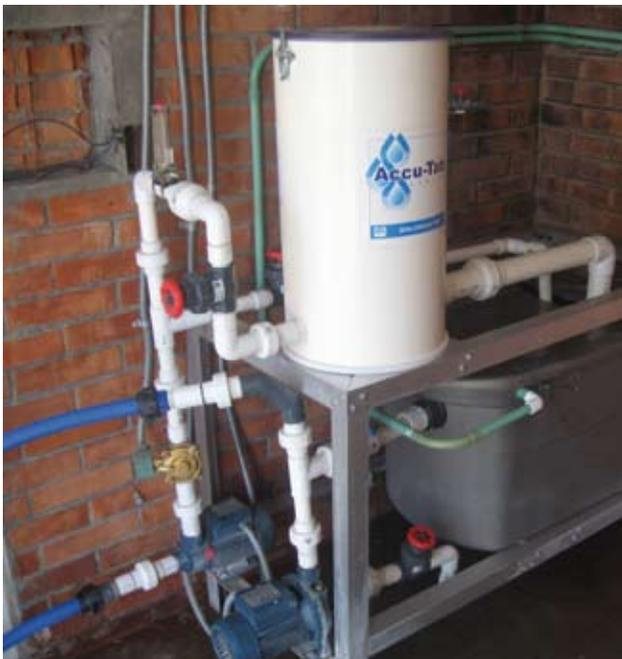
El proyecto dio inicio a mediados del año 2006 con la realización de una prueba en el pozo Marques Infonavit en la Ciudad de Querétaro. Los resultados de la cloración con el sistema de Accu tab, fueron totalmente diferentes a lo que venían obteniendo con el uso del cloro gas licuado. En
